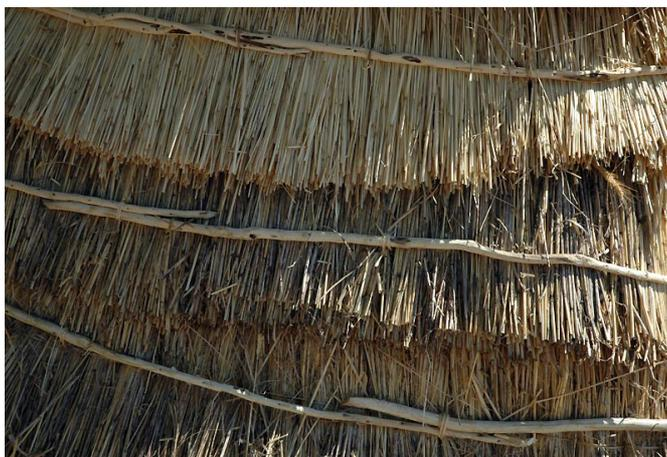
**Fig. 6:** detalle de la colocación de las capas de bálago con las latas de fijación
